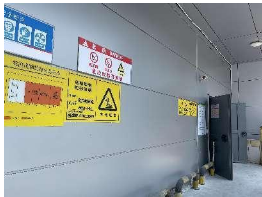
危废暂存间外部
