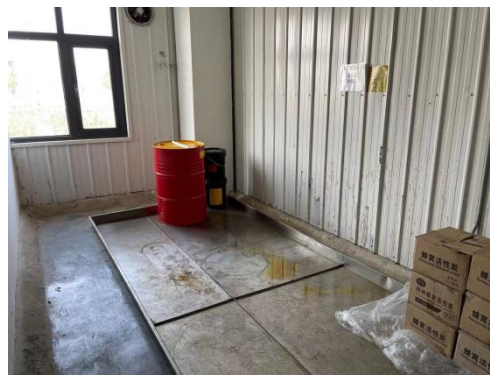
危废暂存间内部
