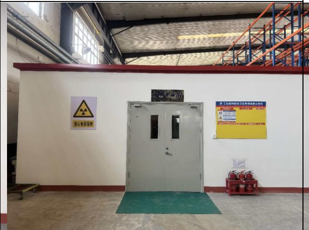
电离辐射警告标志和中文警示说明（探伤工作区）
