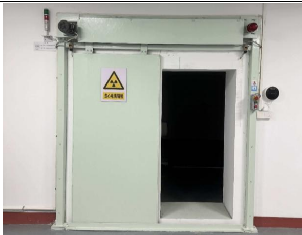
电离辐射警告标志和中文警示说明（探伤室门）
