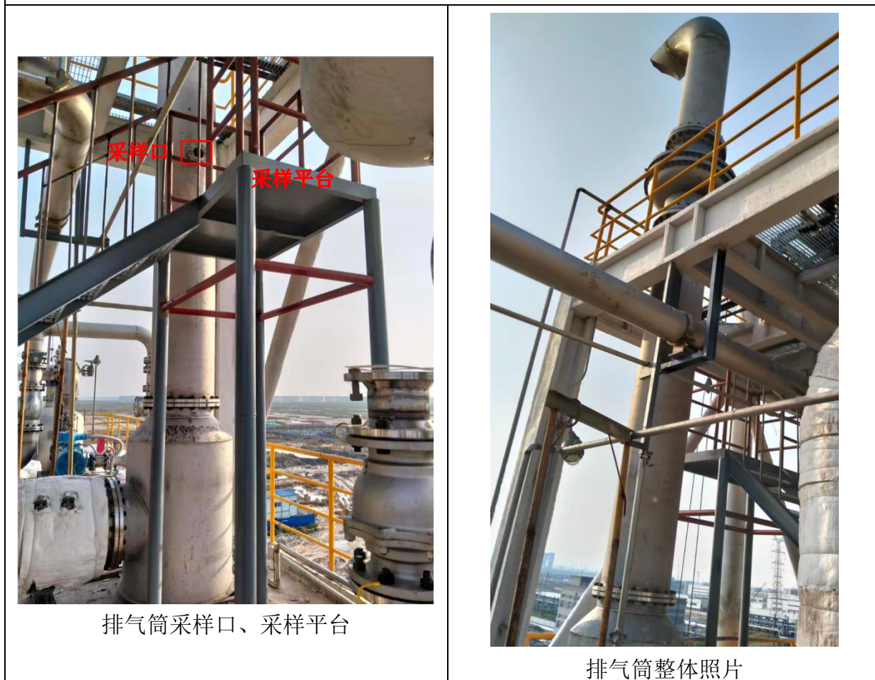
DA006 氢化工序废气排放口 33m
