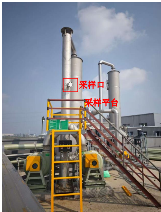
DA002 碳酸钠中转料仓进料废气排放口 25m
