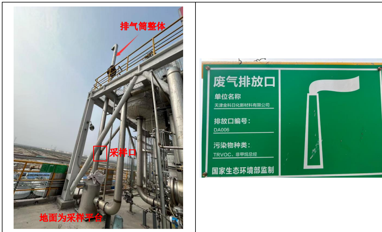
DA006 氢化工序废气排放口 33m
