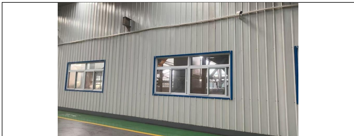
“三床蓄热式 RTO 焚烧”废气处理装置的独立隔声房
