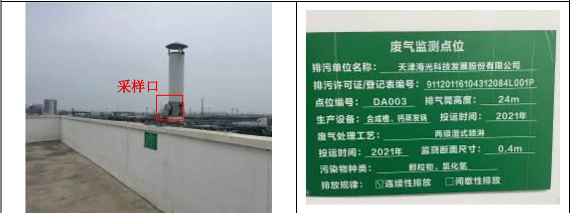
制药二车间氯化钙废气排气筒 DA003
