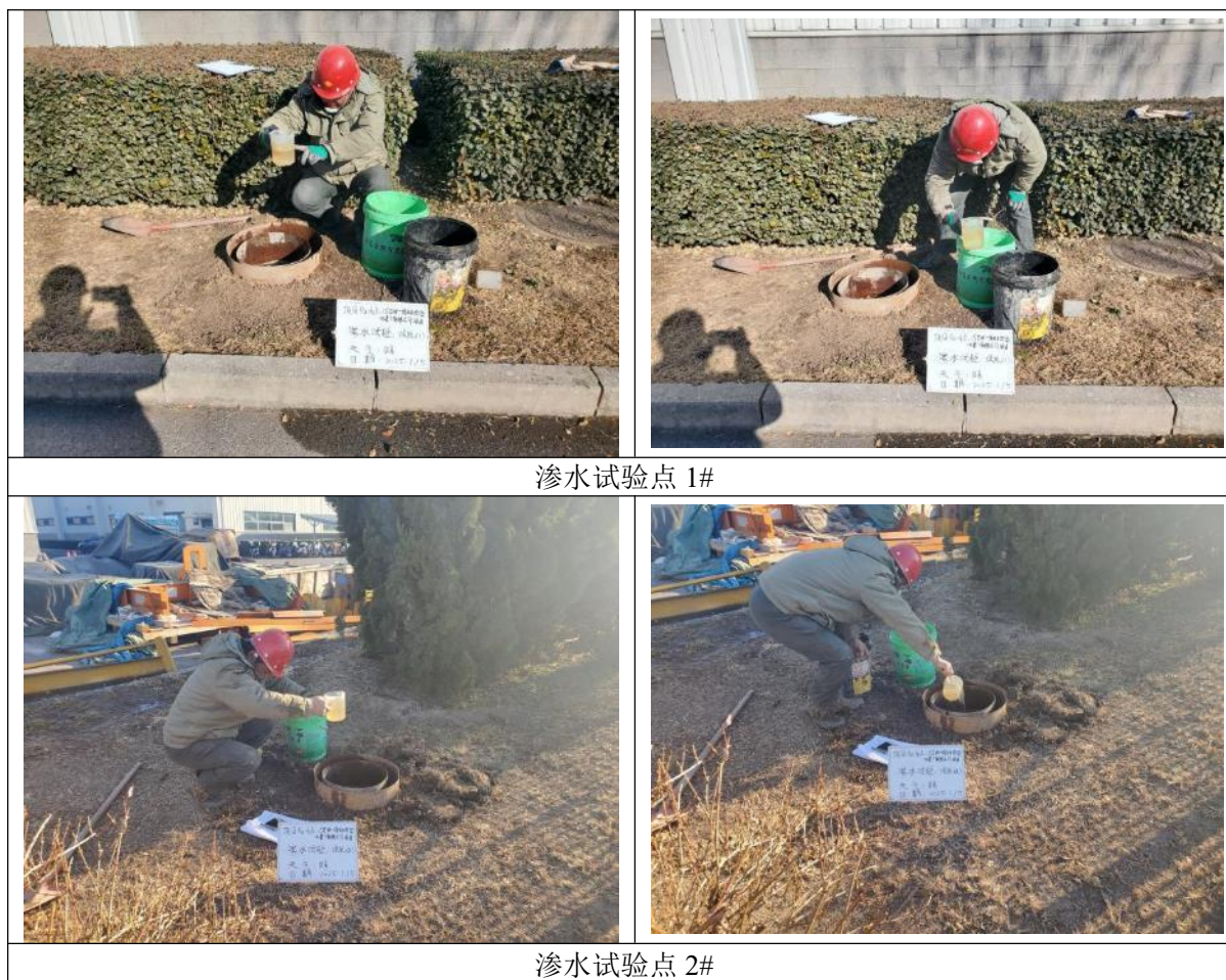
图 3.2-10 现场渗水试验照片
