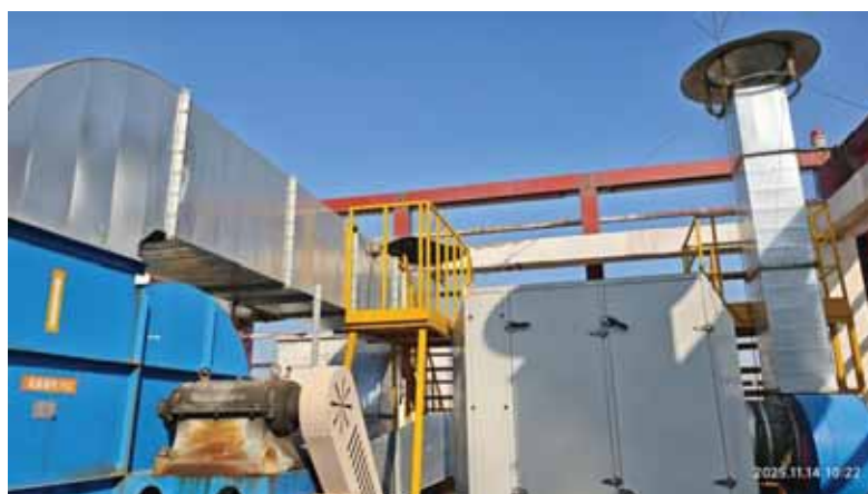
图 2.11-1 南区楼顶废气治理设施
