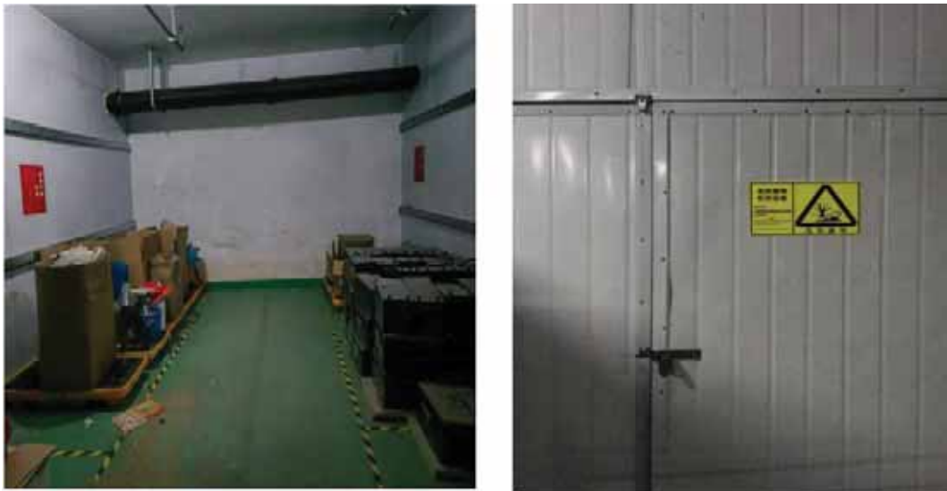
图 2.11-6 现有危废暂存间现场照片
