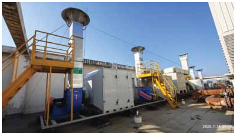
图 2.11-1 南区楼顶废气治理设施
