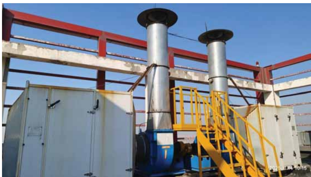
图 2.11-7 北区排气筒规范化设置情况
