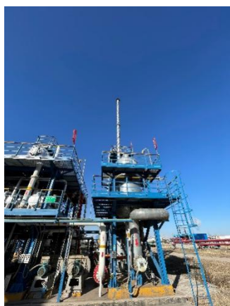
苯乙烯中间罐区 DA003 排气筒
