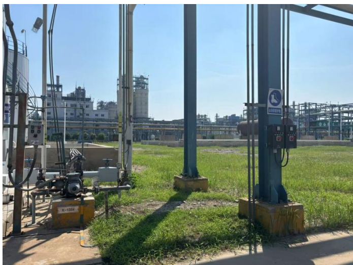
图 1 本项目拟建设位置现状情况
