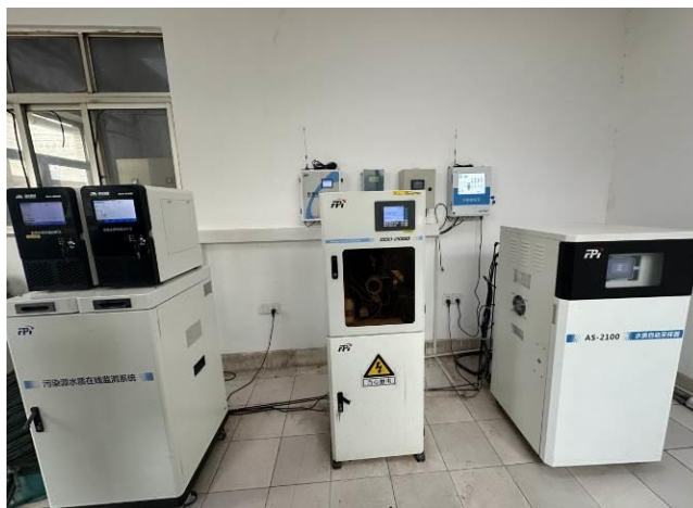
生产废水排放口及在线监测装置
