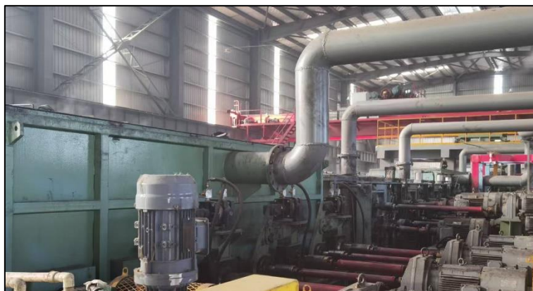
脱脂废气收集设施
