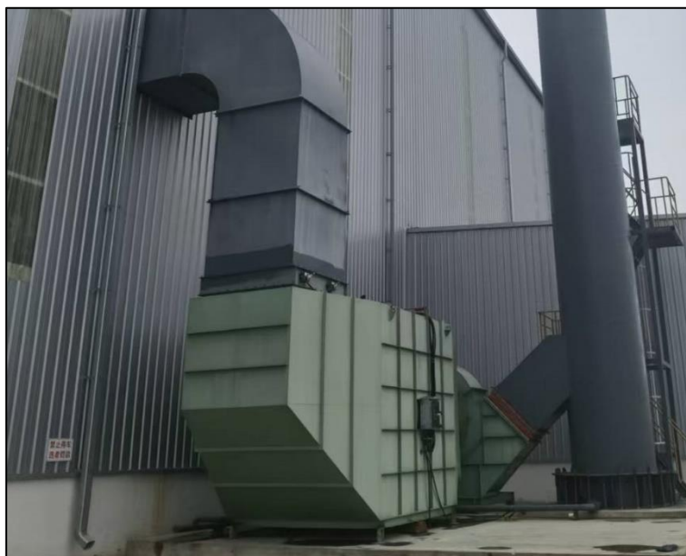
平整废气油雾分离器
