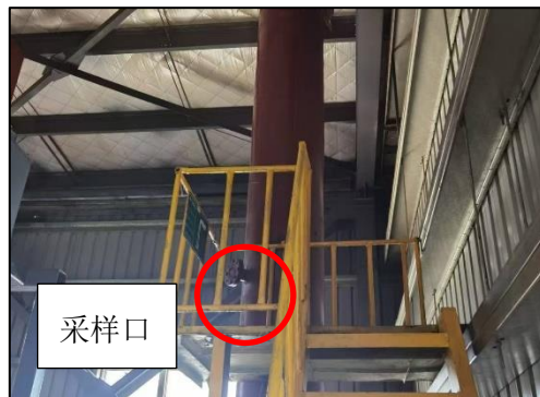
1#蒸汽锅炉烟气排气筒（DA015）
