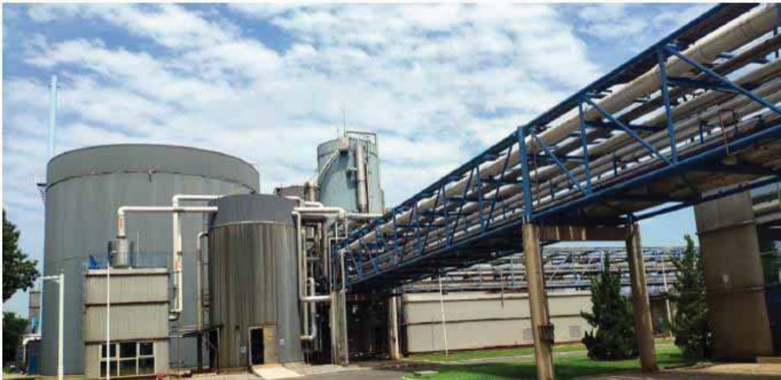
图 3.2-1 现有污水处理站现场照片
