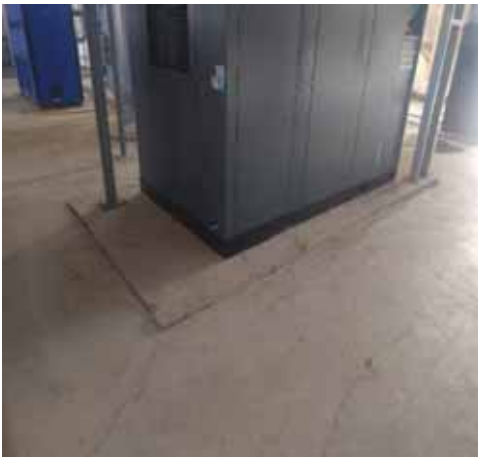
图 4.1-4 餐厅静电式油烟净化器
