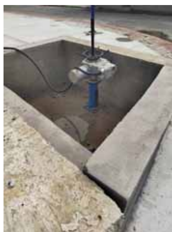
图 4.3-3 雨水排放口截止阀
