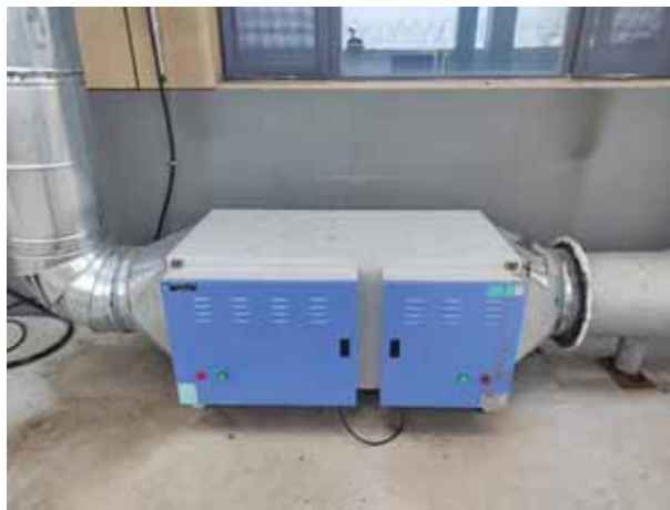
图 4.1-4 餐厅静电式油烟净化器
