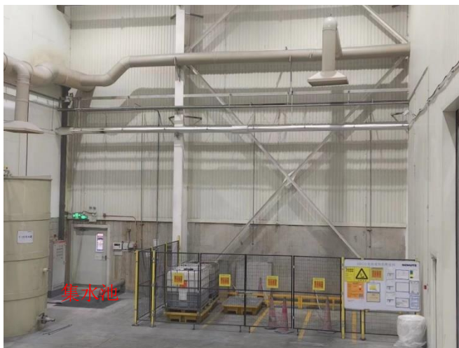
图 2-12 车间现有危险废物暂存间照片
