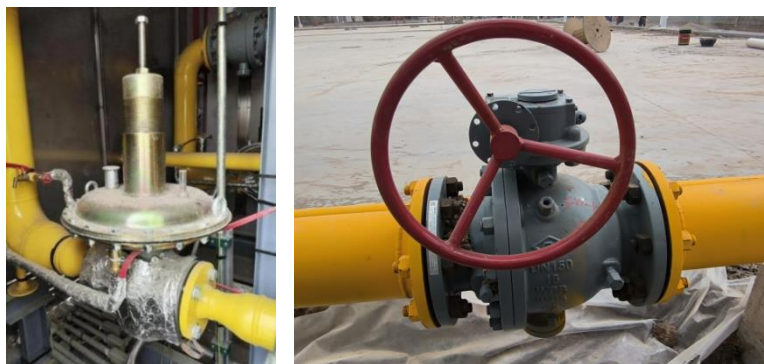
图 2.6-5 天然气管线电磁阀和手动截止阀现场照片
