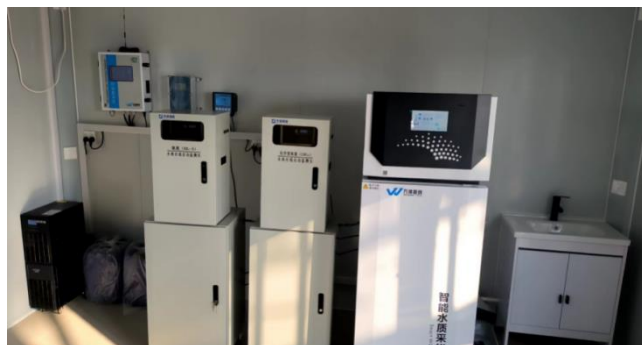
图 2.8-1 厂区污水在线设备照片
