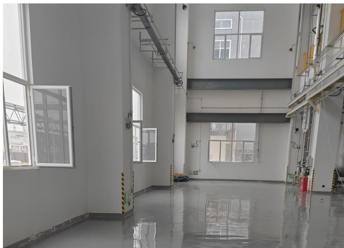
图 3.2-1 厂房预留区域现状
