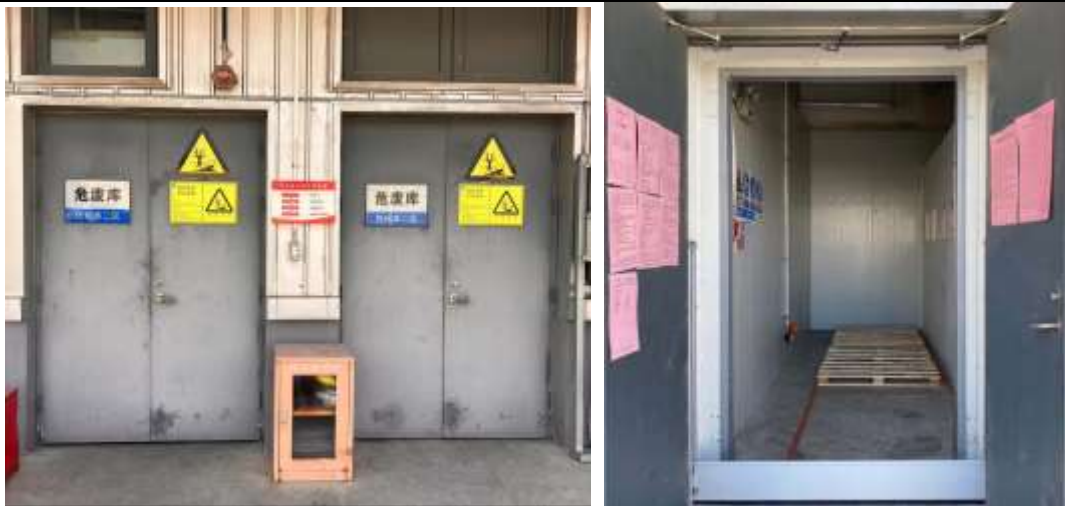
危险废物暂存设施
