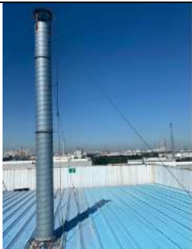
FD 研发质量实验室废气排气筒 (P 4 ) 及标志牌
