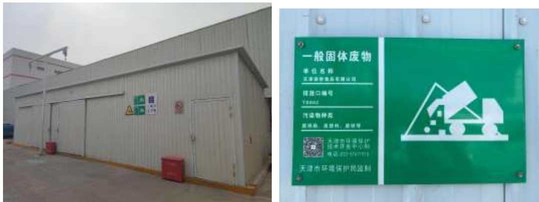
一般固体废物暂存设施
