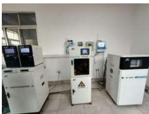
生产污水排放口 DW005 及在线监测装置
