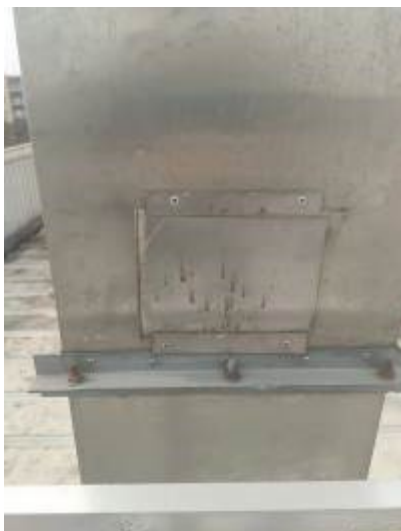
脱硫废气排气筒 DA006
