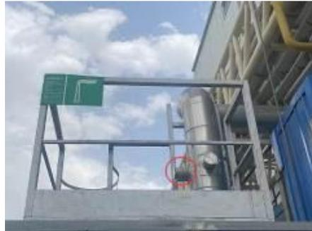
图 2-18 锅炉废气排气筒 (P<sub>1</sub>) 及标识牌
