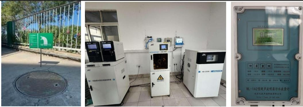
图 2-24 生产污水排放口 DW005 及在线监测装置
