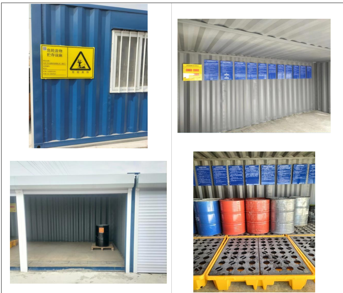
危废暂存间规范化情况
