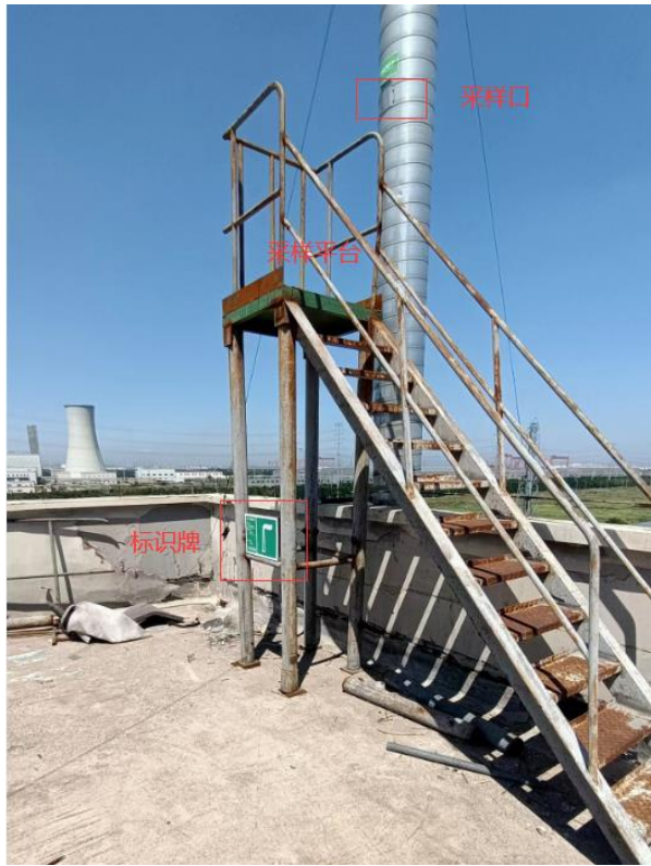
3#小粉料解包、配料粉尘排气筒 DA007
