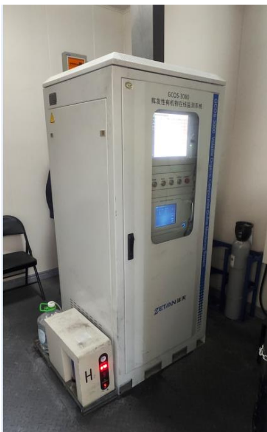
炼胶、压片废气非甲烷总烃在线检测设备
