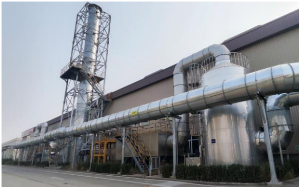
农业子午胎和斜胶工程胎车间硫化废气“喷淋+活性炭吸附+低温等离子”净化装置
