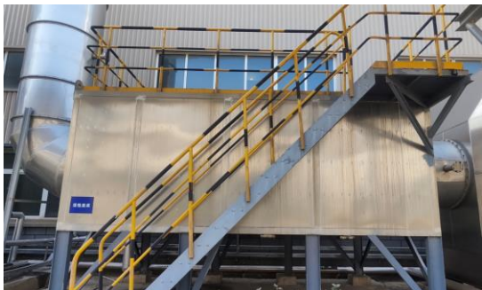
农业子午胎和斜胶工程胎车间硫化废气“喷淋+活性炭吸附+低温等离子”净化装置
