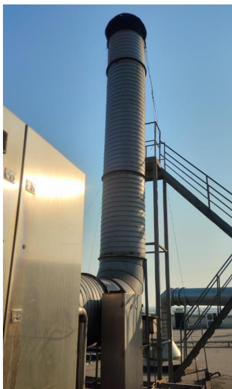
炼胶、压片废气非甲烷总烃在线检测设备
