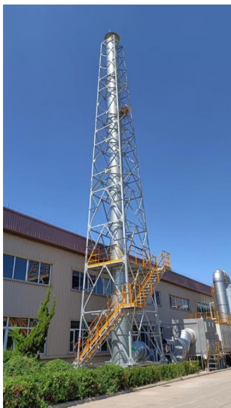
全钢工程子午胎车间热胶废气排气筒 DA016
