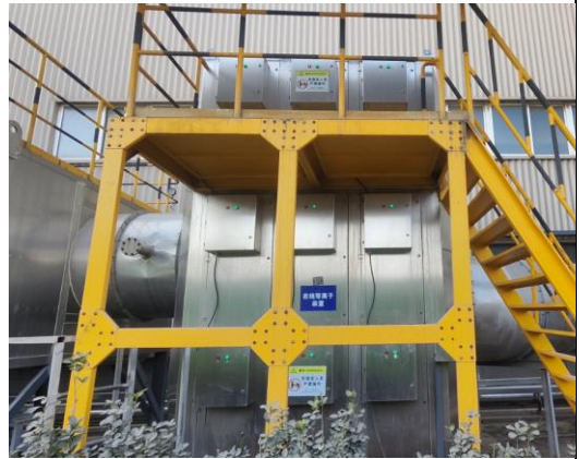
全钢工程子午胎车间硫化废气“喷淋+活性炭吸附+低温等离子”净化装置
