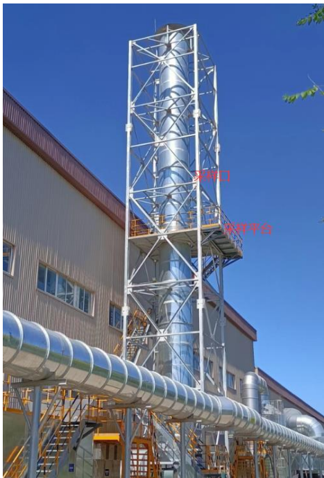
全钢工程子午胎车间硫化废气排气筒 DA017
