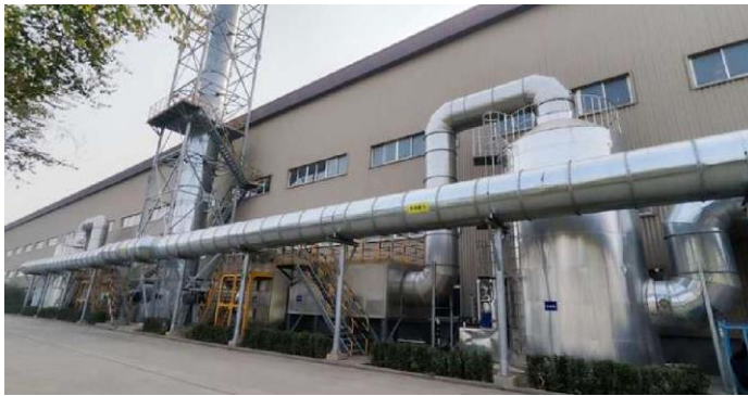
全钢工程子午胎车间硫化废气“喷淋+活性炭吸附+低温等离子”净化装置
