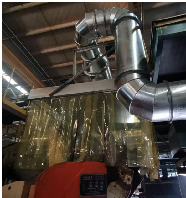
全钢工程子午胎车间复合机出料口集气罩
