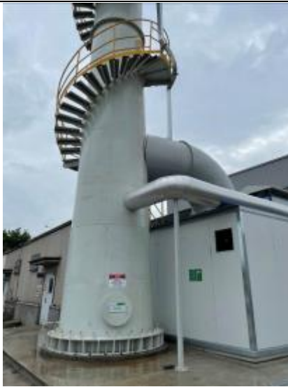
喷涂废有机气排气筒 (DA014)
