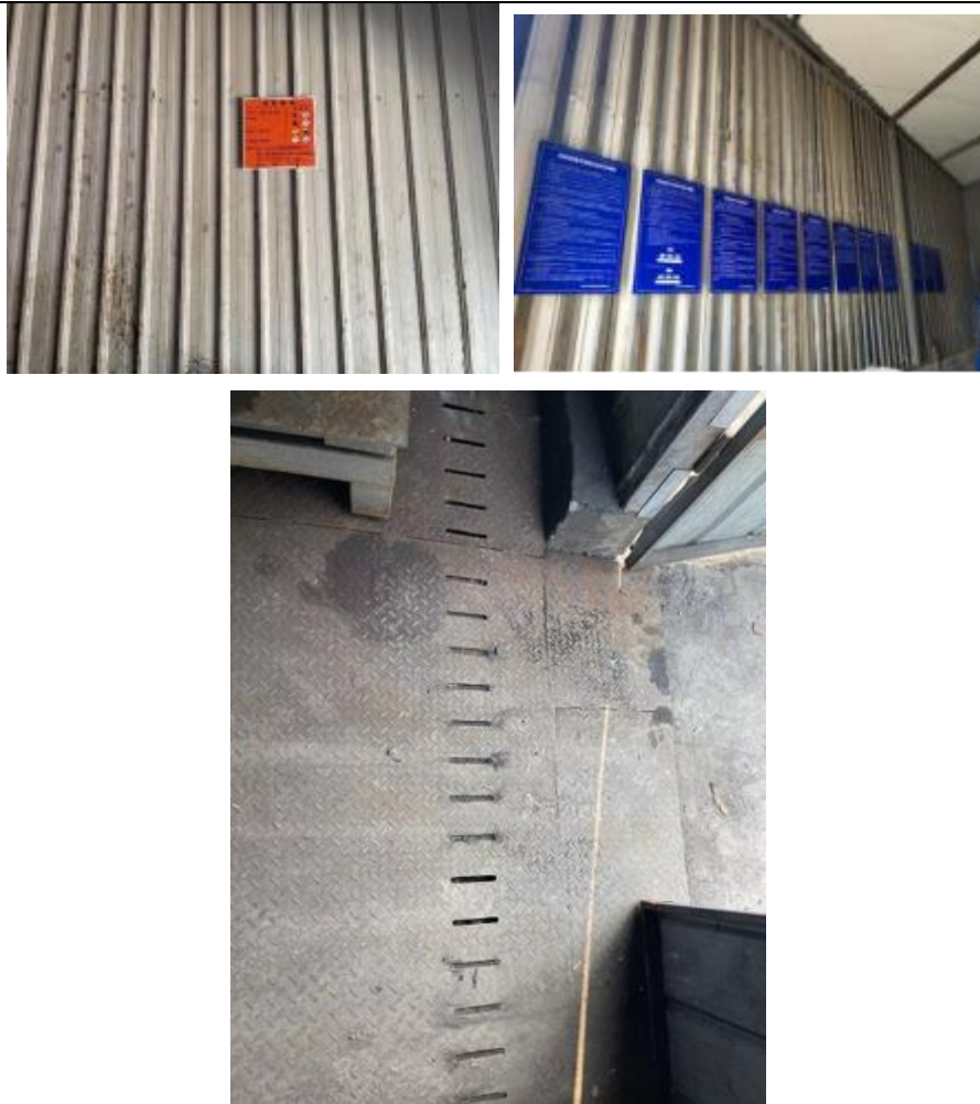
危险废物暂存间
