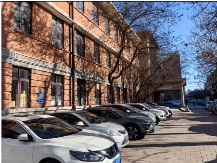
图 2-15 文保建筑现状（C1、C5 正常使用）
