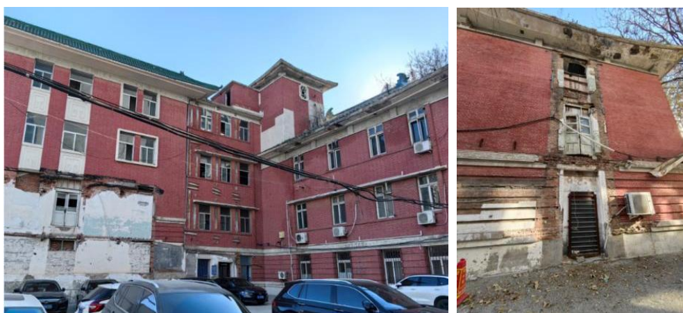
图 2-14 文保建筑现状（C2-C4 闲置）
