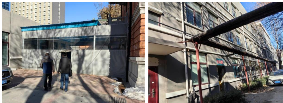
图 2-16 发热门诊现状及附属用房现状
