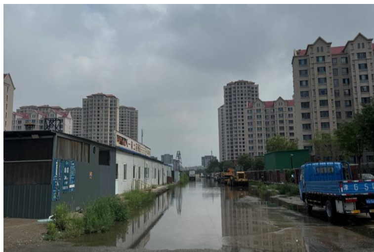
图 2-1 道路现状情况
