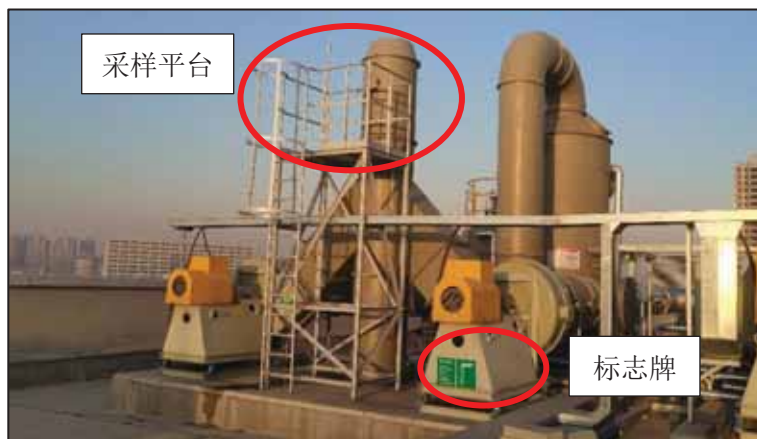
酸性废气排气筒 (P1)
