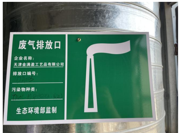
P3 排气筒标识牌
