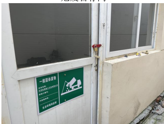
一般固废暂存间
