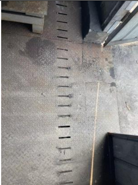
危险废物暂存设施
