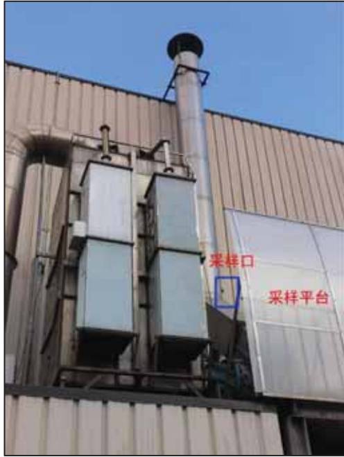
生产废气排气筒 (P2)
