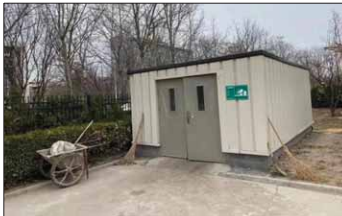
一般固废暂存间
