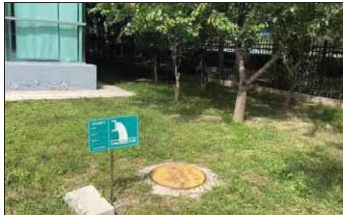
污水总排口 (DW001)
