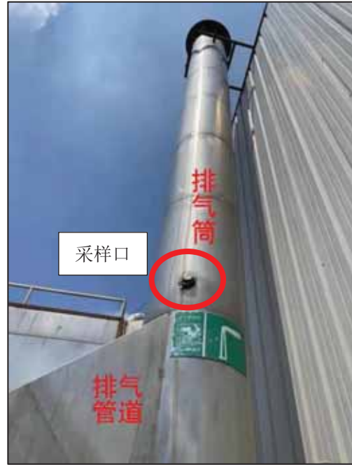
生产废气排气筒 (P2)
