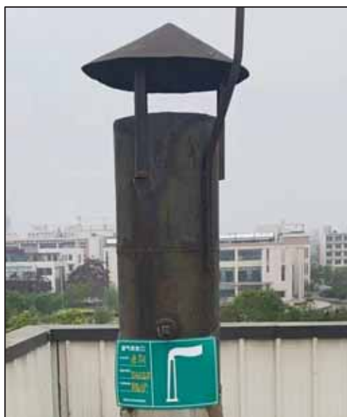
锅炉燃气废气排气筒（P1）
