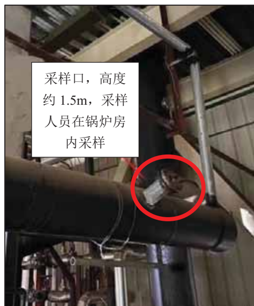
锅炉燃气废气排气筒（P1）
