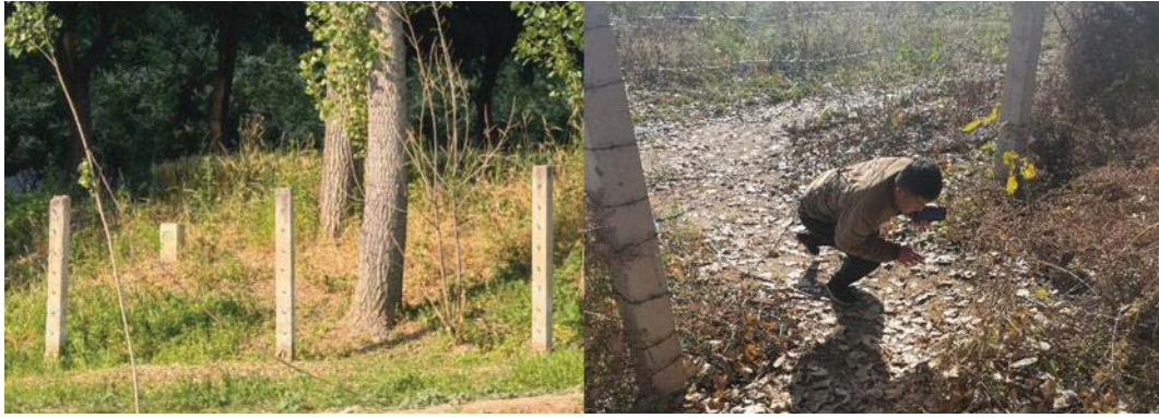
图2.2-2刺绳护栏网现状
