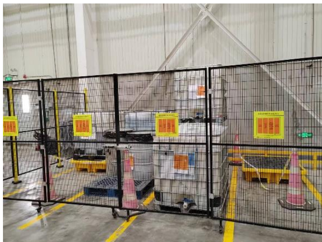
图 2-11 车间现有危险废物暂存间照片
