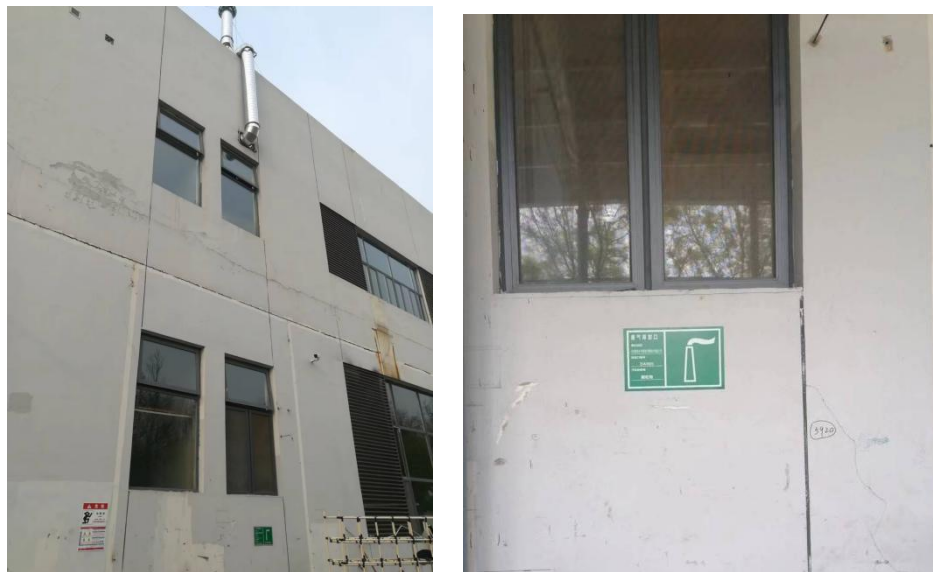
图2-12 焊接烟尘排气筒（DA005）及其标识牌
