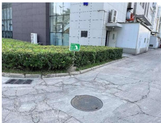
图2-13 厂区废水总排口规范化建设情况
