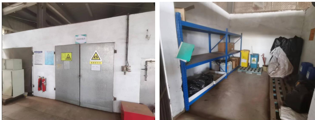
图 3-1 危险废物暂存间
